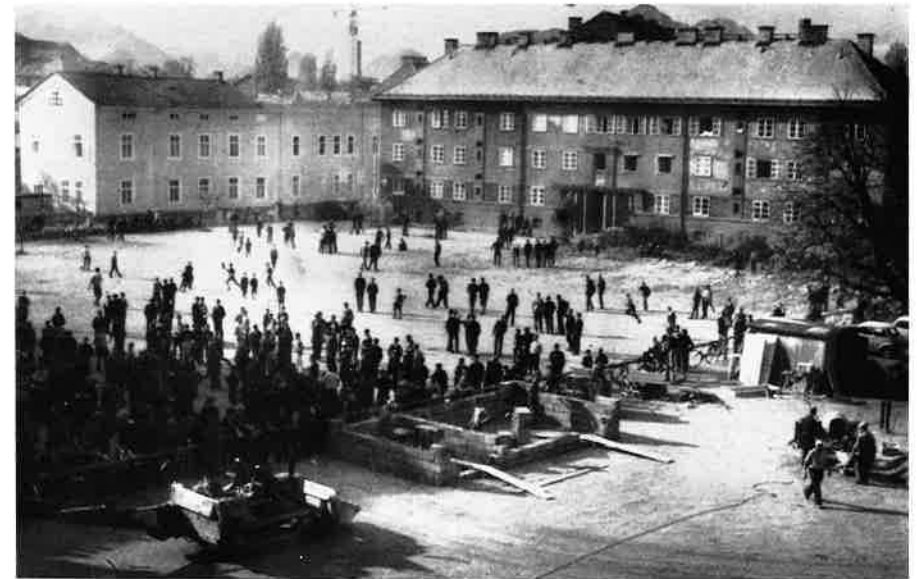
Turnhallen-Neubau: Die Schüler betrachten neugierig den Beginn der Bauarbeiten.
