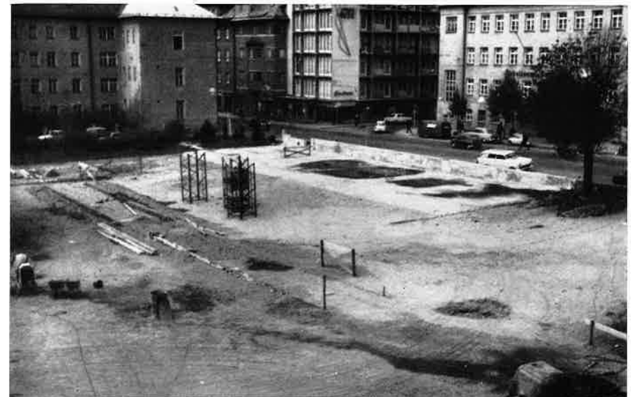
Turnhallen-Neubau: Die Arbeiten beginnen nach dem Abbruch der Garagen im Herbst 1962
